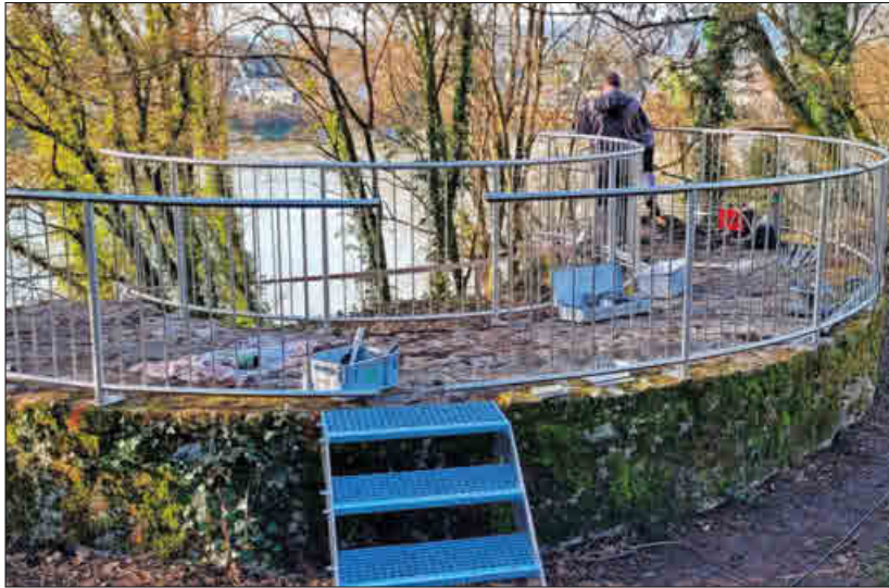
Arbeiten am einstigen römischen Brückenkopf: Das Geländer für die Aussichtsplattform wurde bereits installiert.
